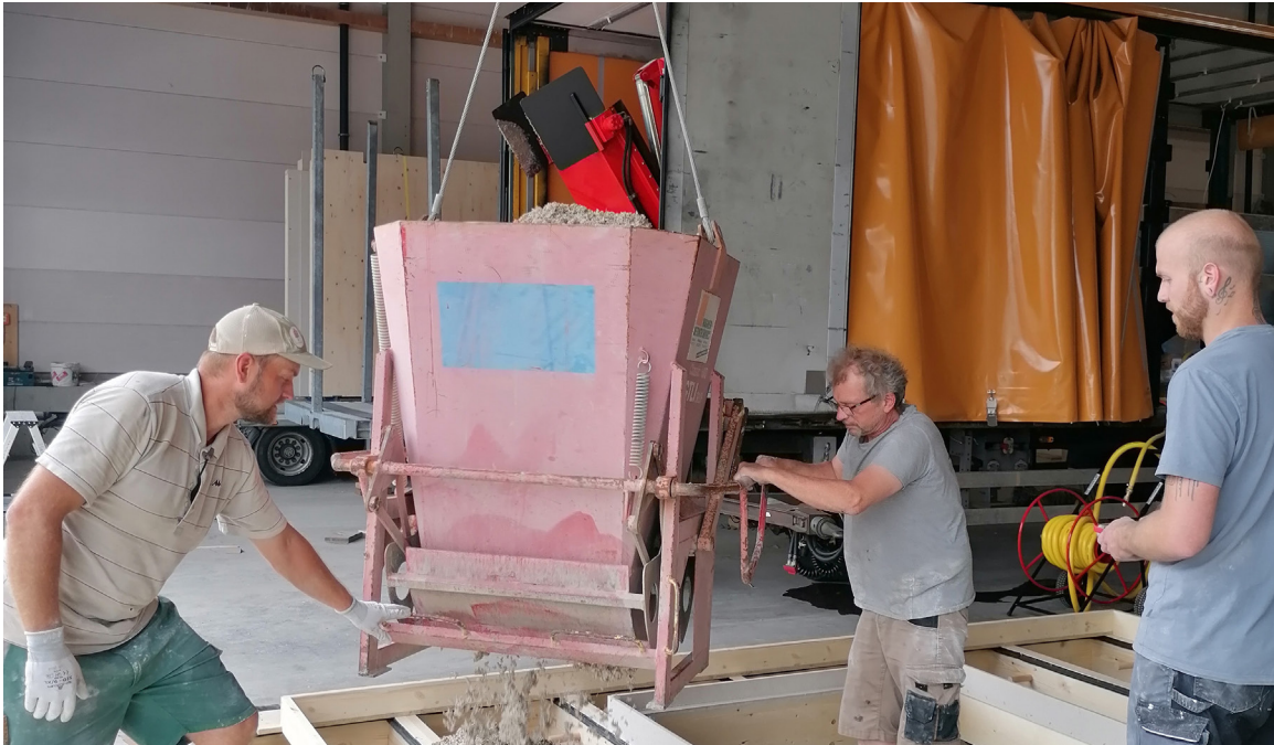
Verarbeitung Hanfbeton Foto: © OPENLY.
