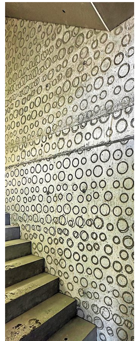
AUS DEM BAUTAGEBUCH: TREPPENHAUS MIT PHOTO- UND PFLANZENKOHLEBETON. FOTO: OPENLY SYSTEMS AG, ALTSTÄTTEN
